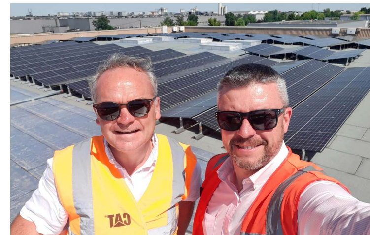
Mise en route de la centrale solaire du nouveau site de GCS en France.
