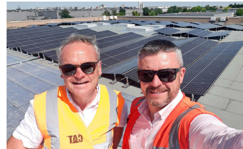
Mise en route de la centrale solaire du nouveau site de GCS en France.
